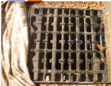
Protection d'un avaloir par géotextile Terrassement et couche de forme
